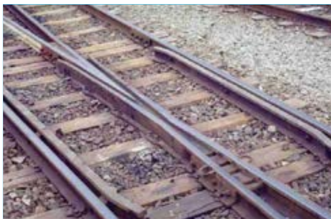
Parts de l'encreuament d'un canvi d'agulles.
