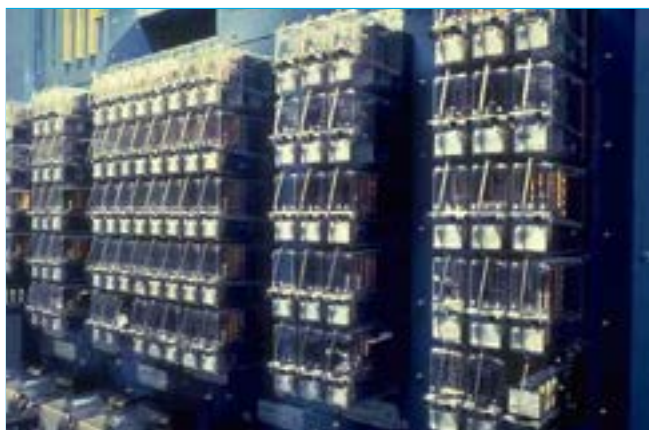
Conjunt de relés d'un enclavament elèctric.
