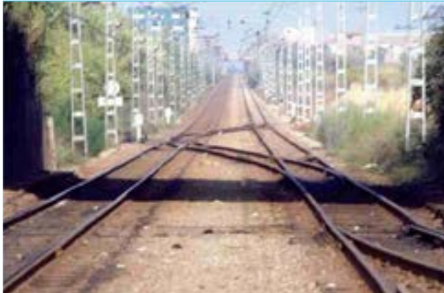
Exemple de combinació d'aparells: escapaments.
